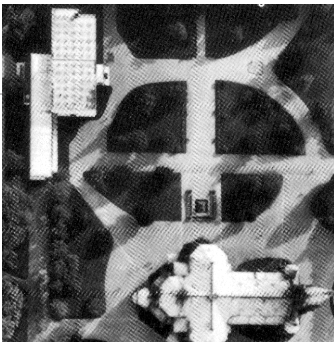
► Die Stadtbibliothek von Viipuri im Gefüge der Parkanlage
